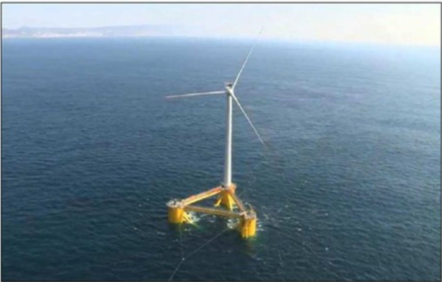
Turbina Eólica Flutuante. Fonte: Recomendação da IALA O-139, "The Marking of Man-made Offshore Structures".
