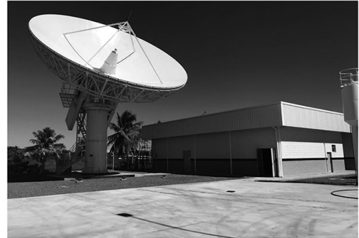
FIGURA 5 - Estação de Acesso – Salvador/BA
